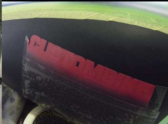
Zur Flammenlackierung kommt der korrekte Schriftzug: Die ausgeplotterte Schrift wird in mehreren Schritten farbig angelegt
